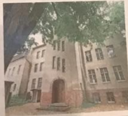
Im Jahr 2025, so der Plan, soll die Evangelische Schule das bis dahin sanierte Schulhaus am Wolgaster Kirchplatz beziehen. Bis zu 200 Mädchen und Jungen sollen hier künftig unterrichtet werden.
